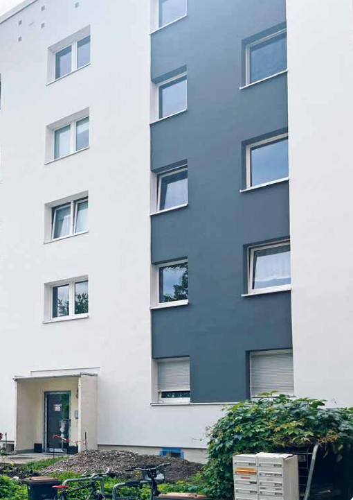
Neue Fassade in der Berliner Straße
